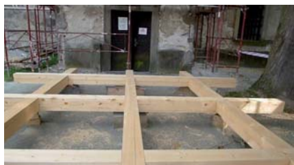
Rozebírání poškozené věže, nový podstavec věže 6.7.2018
