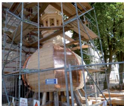
Pokrývání věže měděným pláštěm 3. 8. 2018
