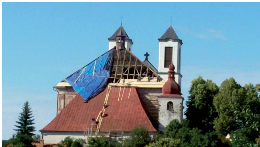
Oprava střechy kostela červenec 2017
