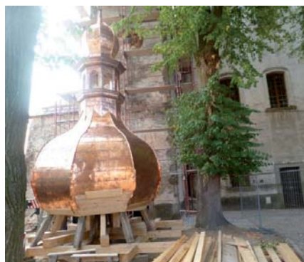
Věž je oděna do měděného pláště 24.8.2018
