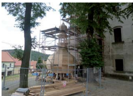
Práce tesařů na věži dne 26.7.2018
