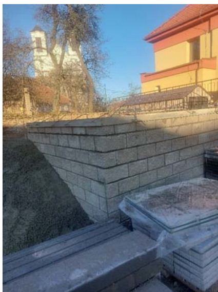
Stavební úpravy stráně na dvoře školy pro venkovní učebnu
