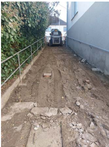
Oprava cesty a zrušení schodů u prodejny COOP
